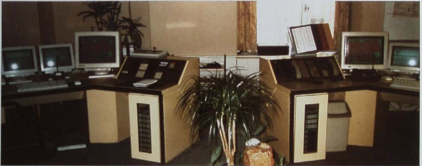
2 der insgesamt 4 Hauptfunkplätze, links Kanal 10, rechts Kanal 28
