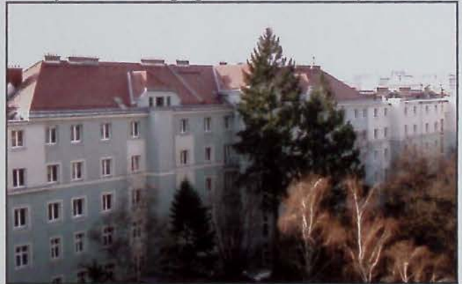
Hoffassade Haus Possingergasse 57 - Herbststraße
