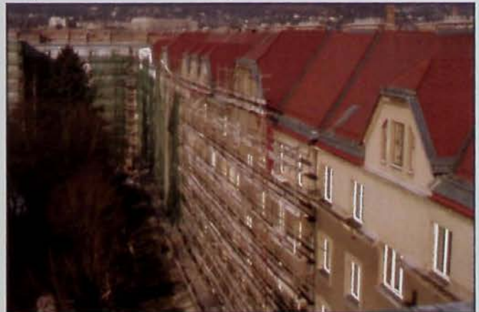
Fassadenarbeiten Hofseite Possingergasse 57
