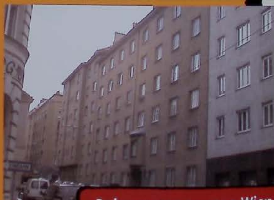
Rainergasse 21, 1040 Wien Fernwärmeeinbau 2002
