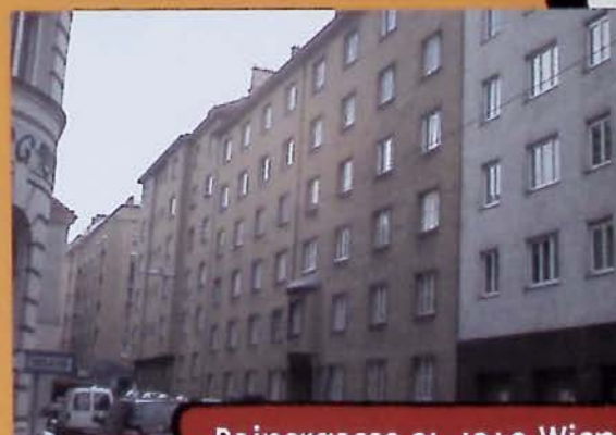
Rainergasse 21, 1040 Wien Fernwärmeeinbau 2002
